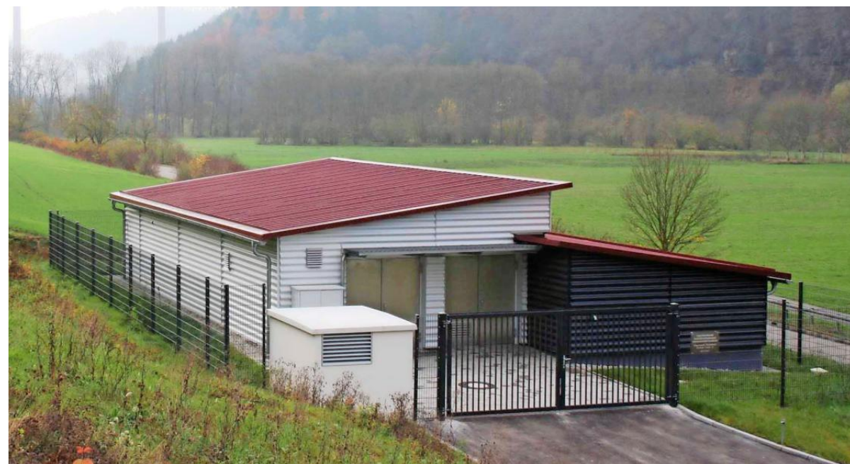
Das neue Wasserwerk Grimm bach bei Braunsbach in der Nähe der Kochertalbrücke.
